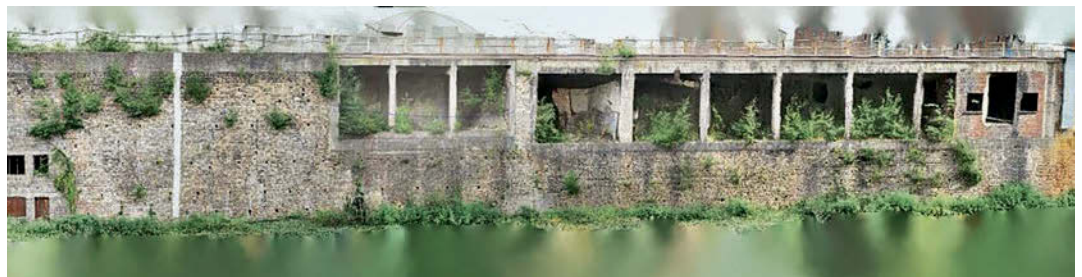
An einer massiven, 286 Meter langen und elf Meter hohen Stützwand in Camphausen prüften die Wissenschaftler, wie sich Defekte in tieferliegenden Schichten erkennen lassen.
